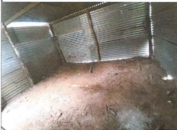
Foto1: Mejoramiento de piso cerámico
