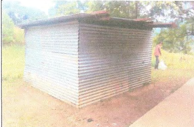
Foto 2: Mejoramiento de pared y techo
